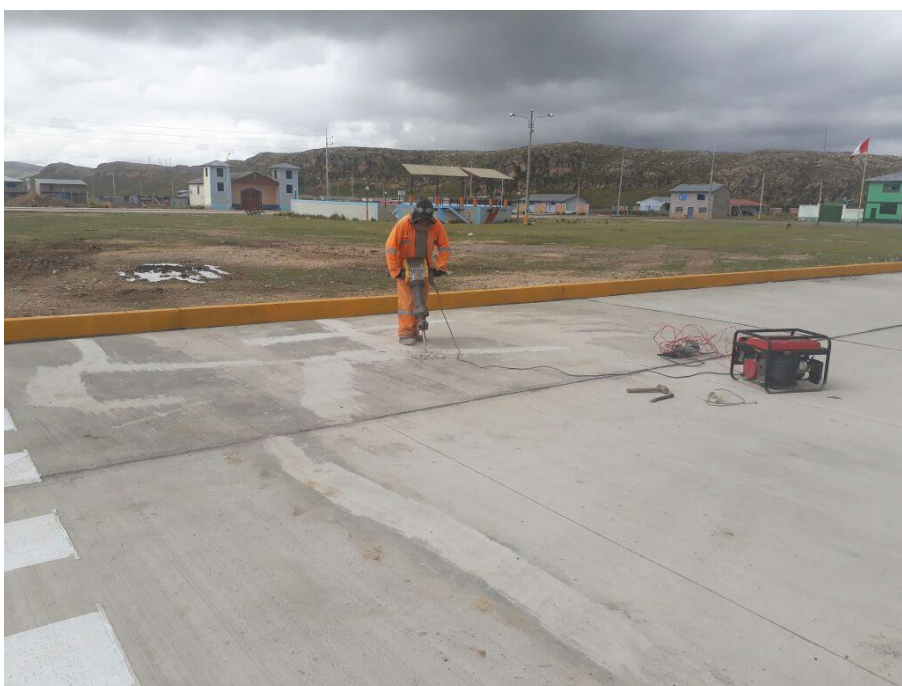
Ilustración 9: Demolición de Pavimentos con Fisuras
