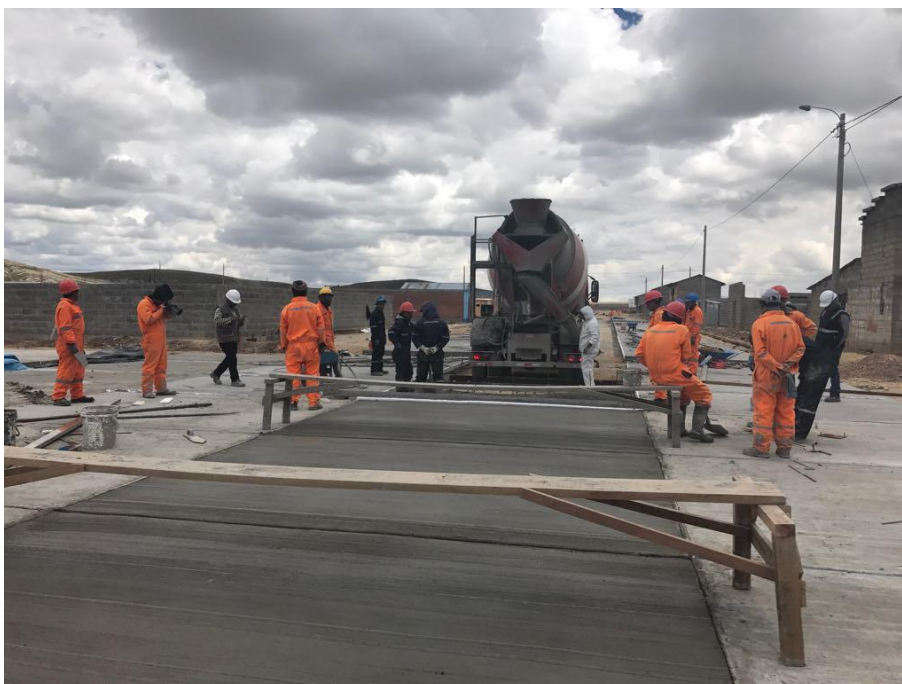
Ilustración 7: Vertido de Concreto Masivo
