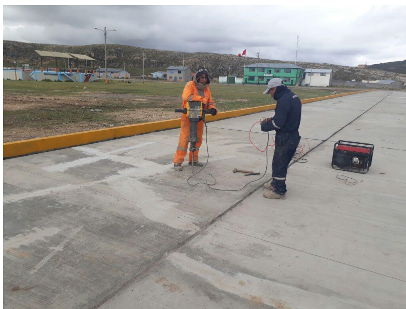
Ilustración 5: Paños con fisuras Obra Cochamarca (Fuente: propia)
