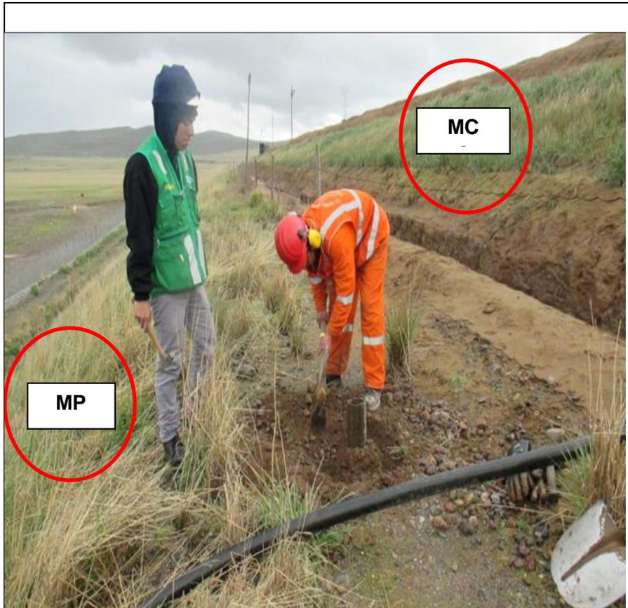
Se aprecia las muestras del talud con relación H:V de 2 a 1 (Horizontal:Vertical), en dique construido con material de préstamo y con material convencional.
