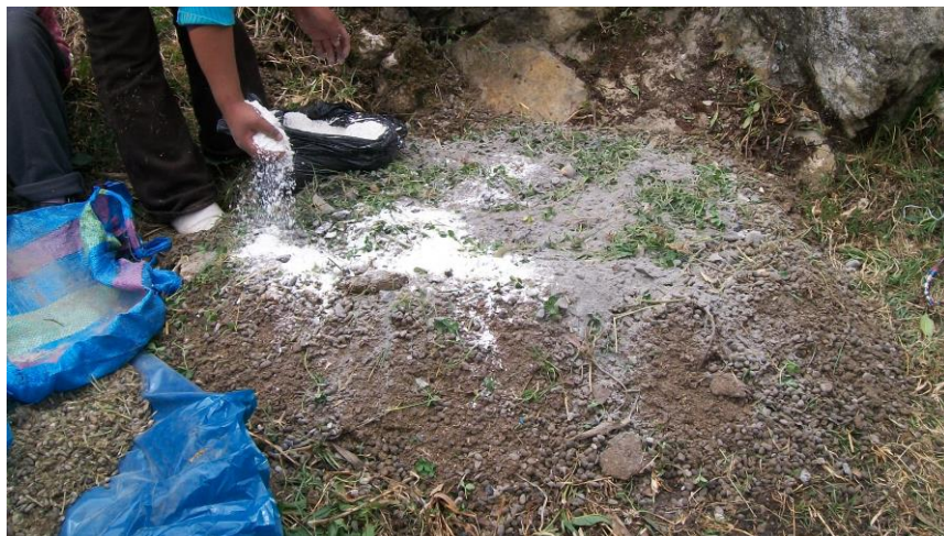
FIG 4. APLICACIÓN DE LA CAL
