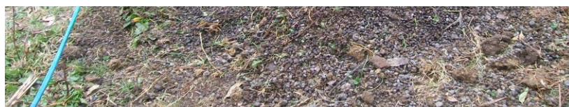
FIG 10 RIEGO PARA UNIFORMIZAR LAS CAPAS
