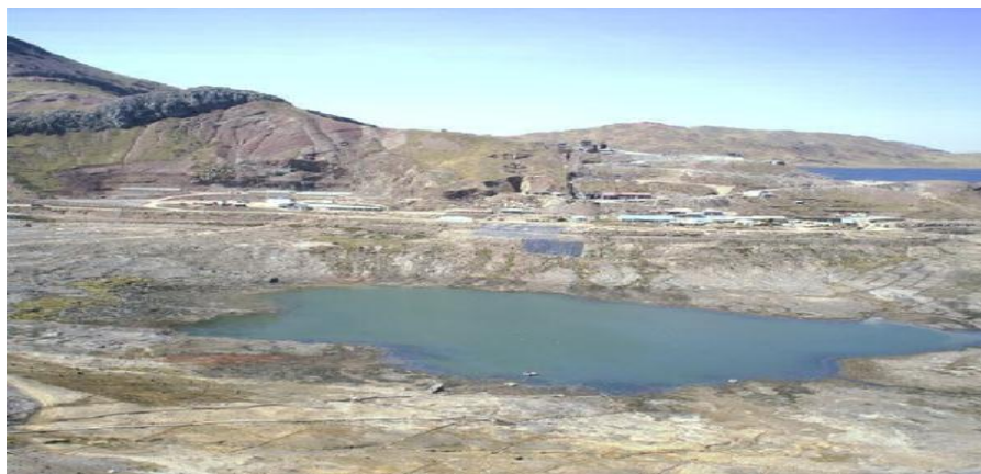
Foto N° 1 Vista Panorámica de la mina
