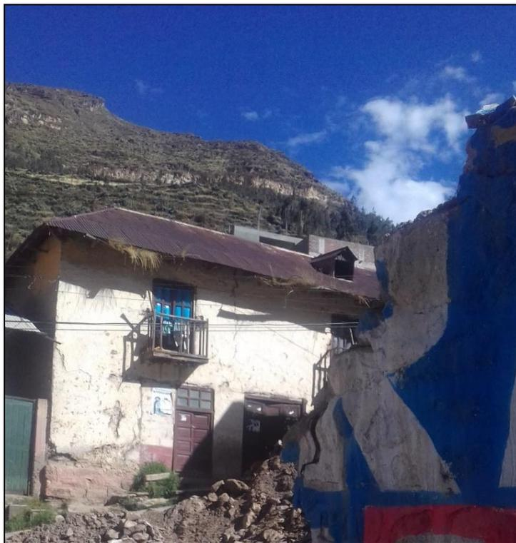
*Fotografía 37.* Vivienda de Tapial con cobertura y paredes en estado deteriorado (Vulnerabilidad alta).
