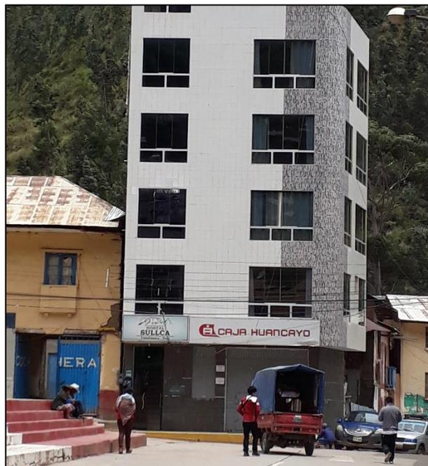
*Fotografía 41.* Edificación con adecuada distribución de masas y vanos (Vulnerabilidad Baja).
