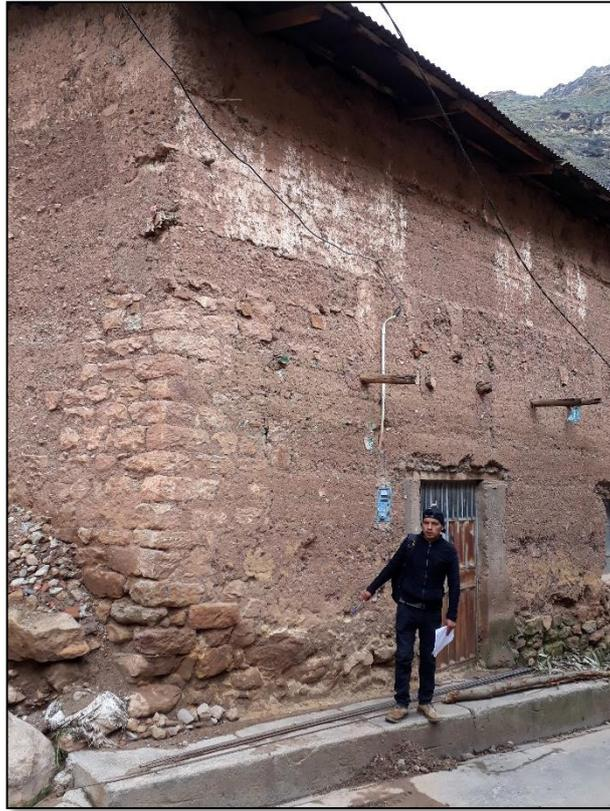
*Fotografía 10.* Vivienda de Tapial con presencia de humedad en la cimentación (Vulnerabilidad Alta).
