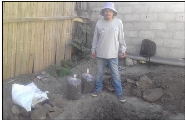
*Fotografía 2. Excavación de calicata N° 02.*
