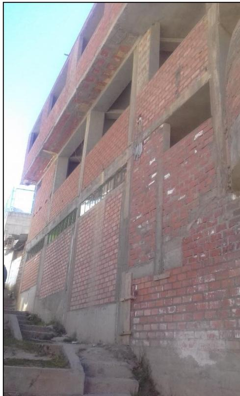
*Fotografía 9.* Vivienda de Albañilería con presencia de columna corta, también se presencia la deficiente proceso constructivo (Vulnerabilidad Media).
