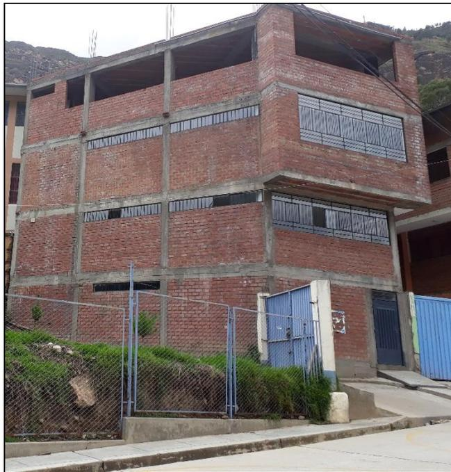
*Fotografía 43.* Adecuada colocación de ladrillos y muros confinados con columnas y vigas solera (Vulnerabilidad baja).
