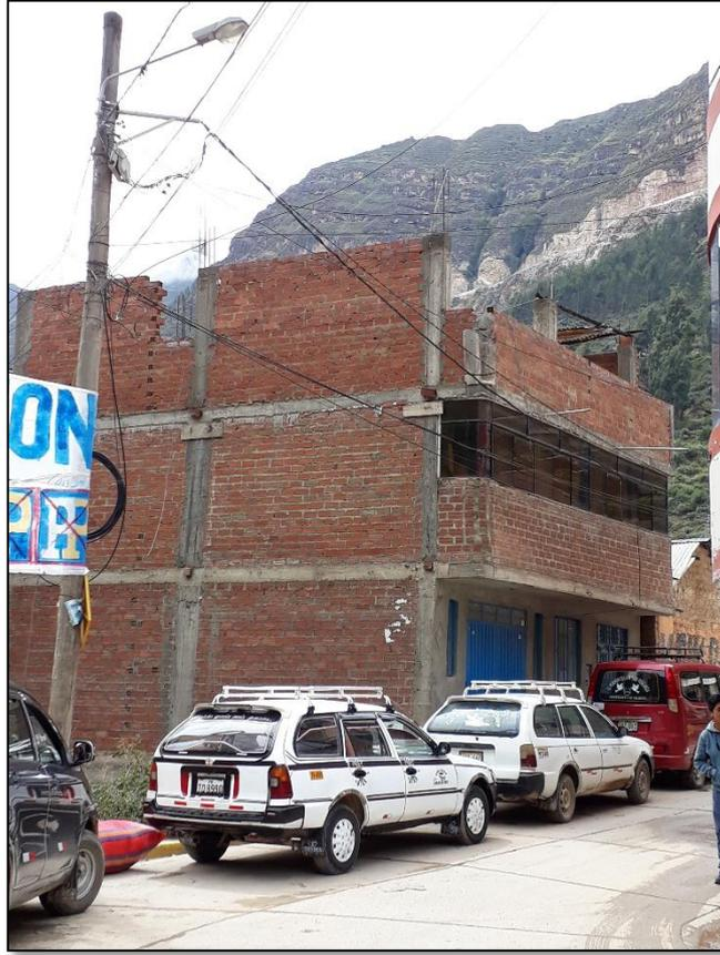
*Fotografía 22.* Vivienda sin culminación con su construcción, falta confinamiento de muros, y falta conectar correctamente parapetos (Vulnerabilidad media).
