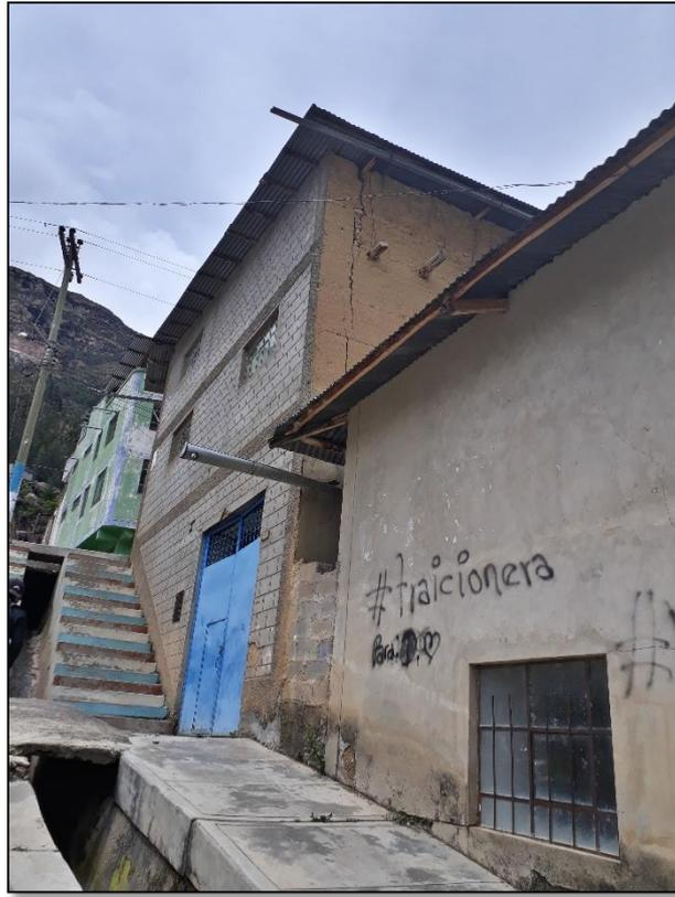
*Fotografía 32. Vivienda de Tapial con agrietamiento (Vulnerabilidad Alta).*
