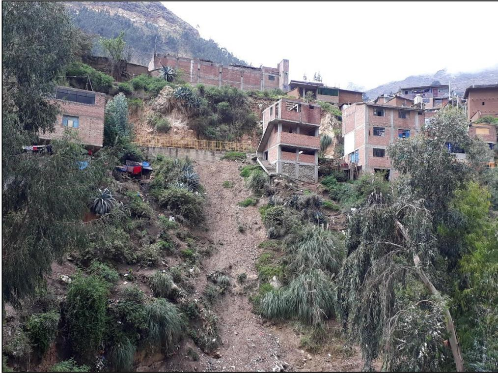
*Fotografía 28.* Viviendas construidas en zonas con pendiente elevada y presencia de deslizamientos (Vulnerabilidad Alta).
