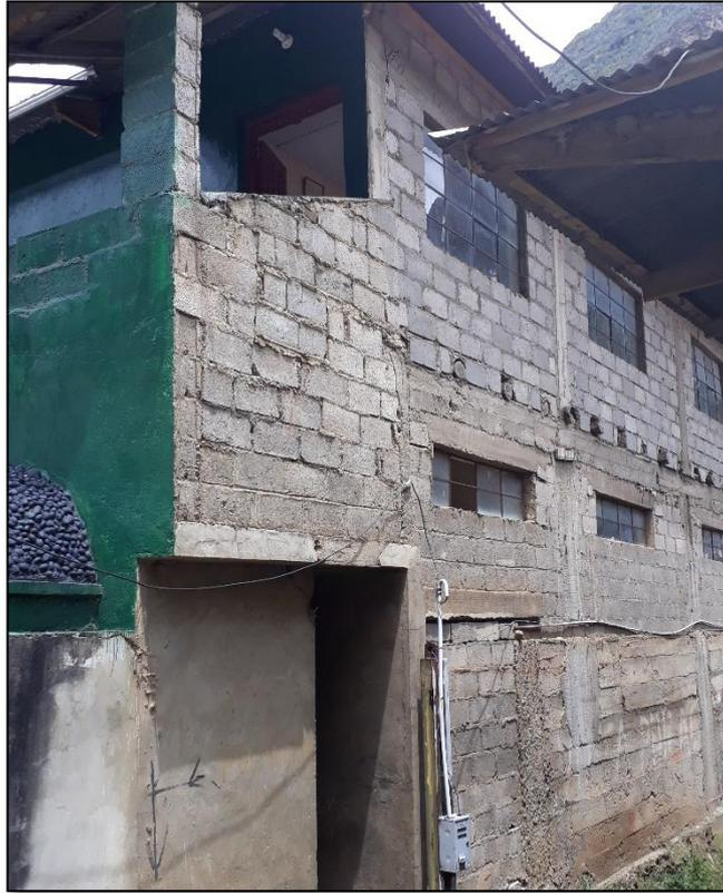
*Fotografía 42.* Proceso constructivo deficiente, sin presencia de columnas, se observa cambio de rigideces (Vulnerabilidad alta).
