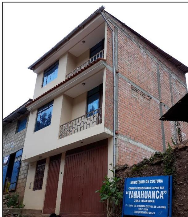
*Fotografía 11.* Vivienda de Albañilería con cambio de rigidez, debido que presenta cobertura liviana y pisos abajo presencia de losa aligerada (Vulnerabilidad Media).
