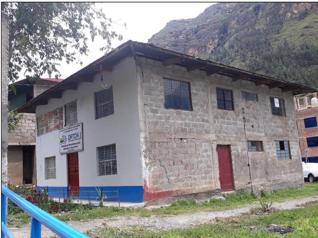
*Fotografía 35.* Edificación de albañilería de bloque de concreto agrietado y en pésimas condiciones para ser ocupada (Vulnerabilidad alta).
