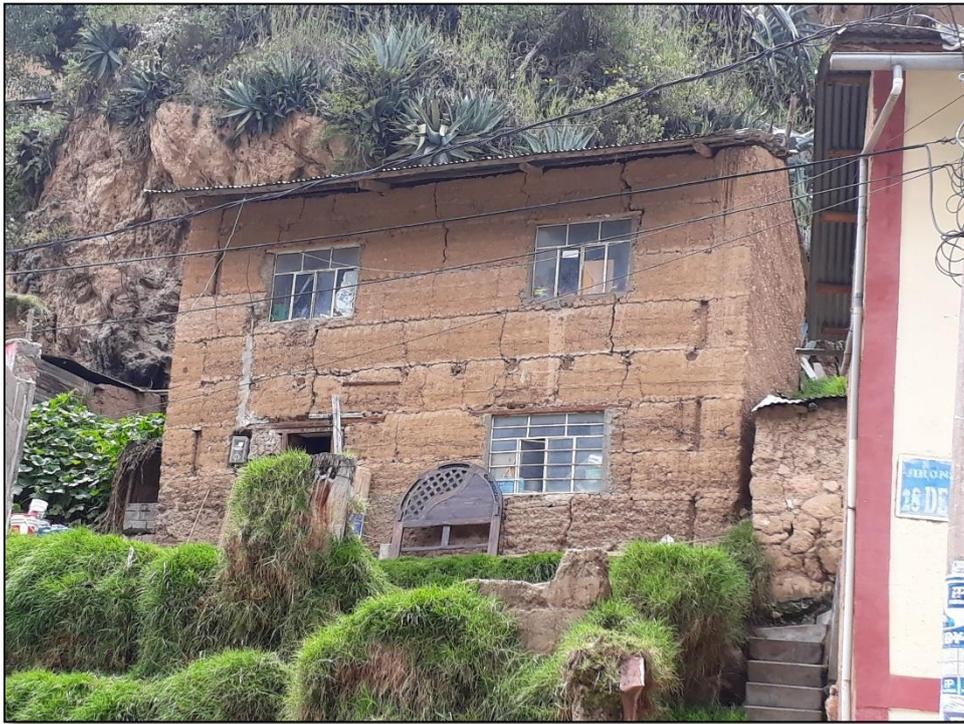
*Fotografía 34.* Vivienda habitada con agrietamiento en estado deplorable (Vulnerabilidad Alta).
