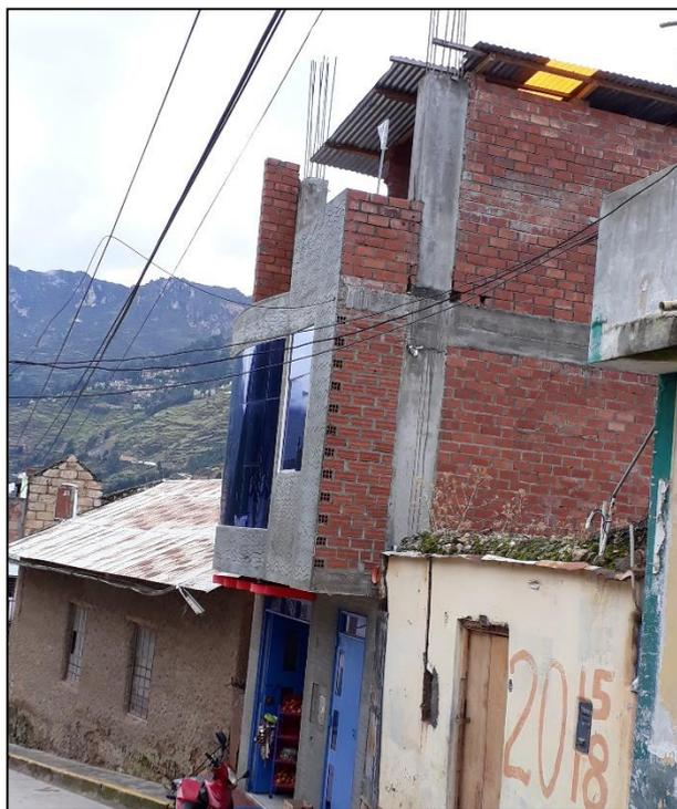
*Fotografía 8.* Falta conectar correctamente parapeto al sistema resistente, carencia de viga solera sobre muro de albañilería y falta viga para conectar correctamente con las columnas (Vulnerabilidad Media).
