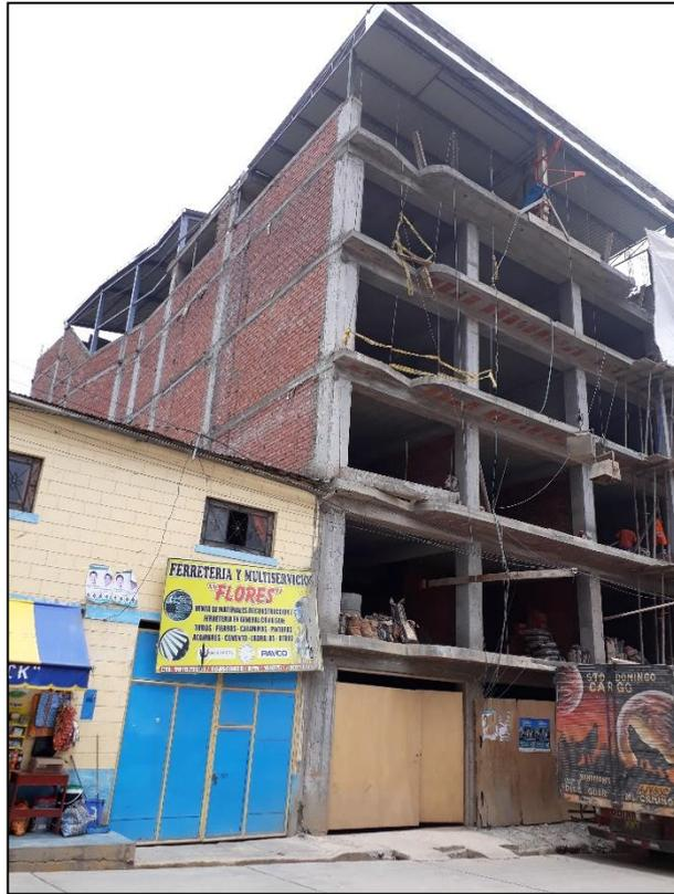
*Fotografía 40.* Edificación de sistema aporticado (Concreto armado) en etapa final de construcción, correctamente conectada (Vulnerabilidad Baja).
