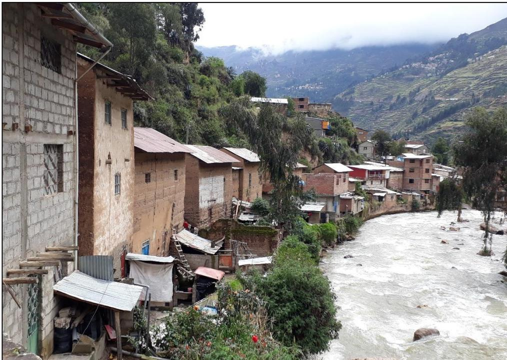
*Fotografía 29.* Viviendas construidas a la orilla del río, con peligro de desborde y socavación (Vulnerabilidad Alta).
