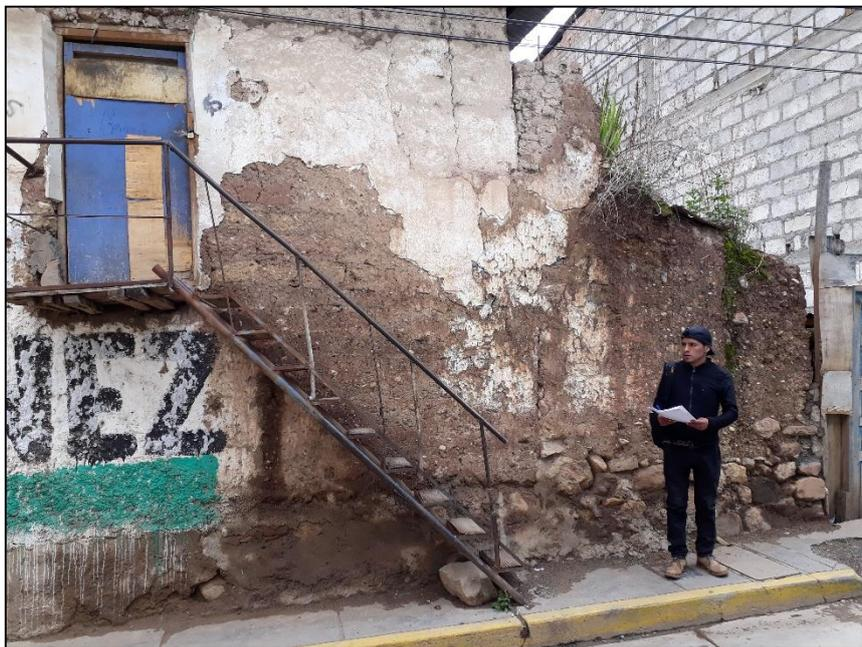
*Fotografía 21.* Vivienda de tapial con humedad en muros y cimentación (Vulnerabilidad Alta).
