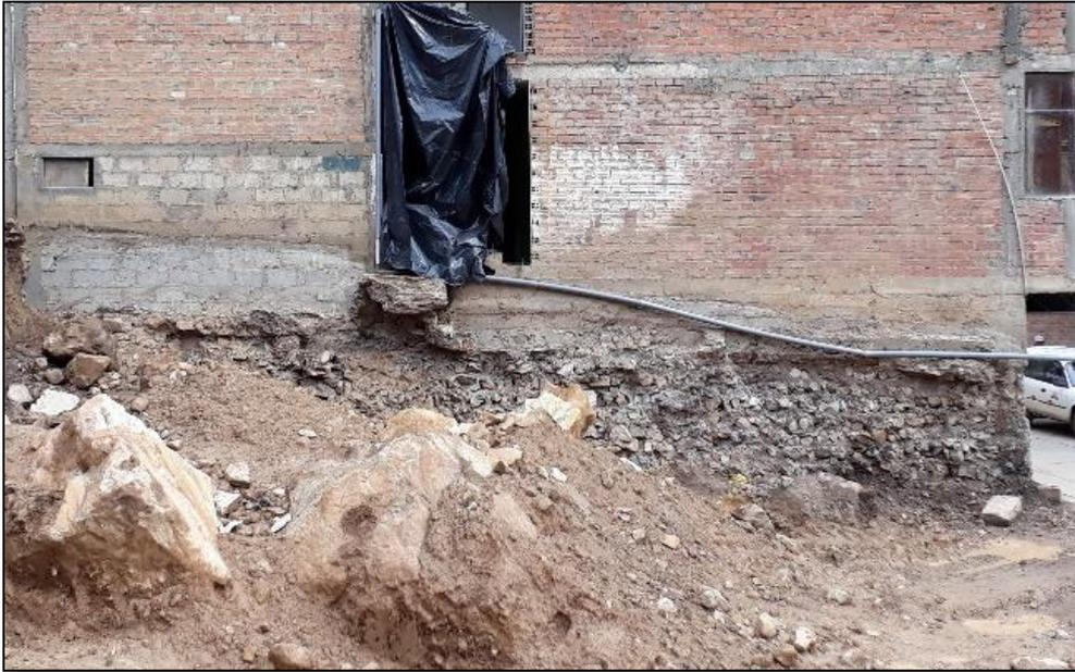
*Fotografía 6.* Cimentación deficiente de vivienda de Albañilería, cambio de rigidez (Vulnerabilidad Alta).
