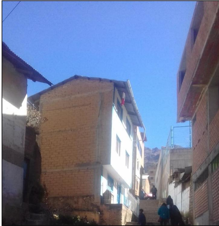
*Fotografía 38.* Edificación de adobe confinada con columnas y vigas (Vulnerabilidad media).
