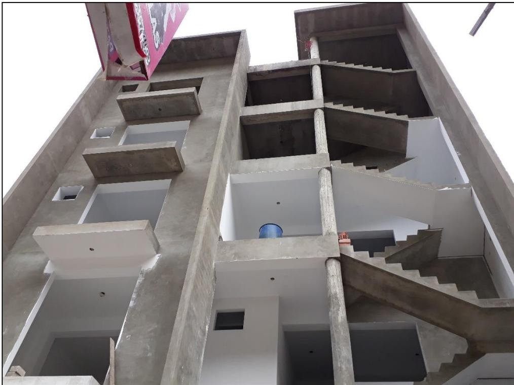
*Fotografía 19.* Edificación de concreto armado, elementos conectados correctamente al sistema resistente (Vulnerabilidad Baja).
