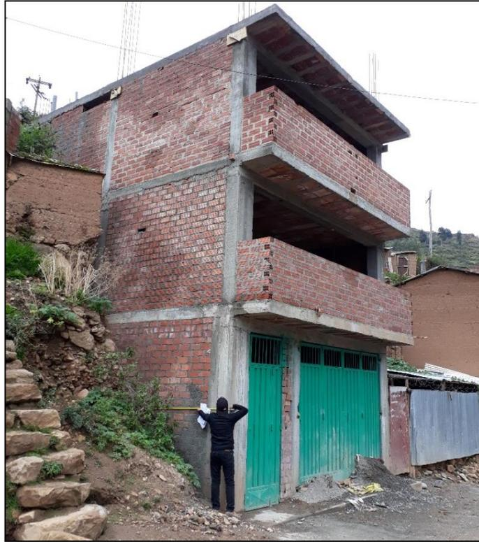
*Fotografía 16.* Vivienda de albañilería con parapetos mal conectados al sistema resistente (Vulnerabilidad Media).
