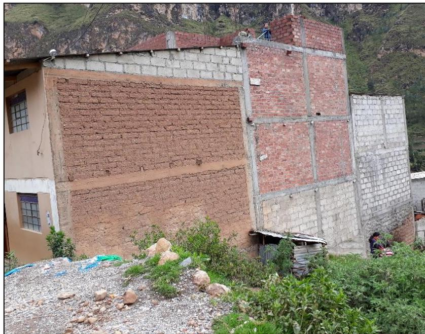
*Fotografía 15.* Viviendas de Adobe y albañilería con cambio de rigideces debido a que presentan dos tipos de materiales en cada nivel (Vulnerabilidad Media).
