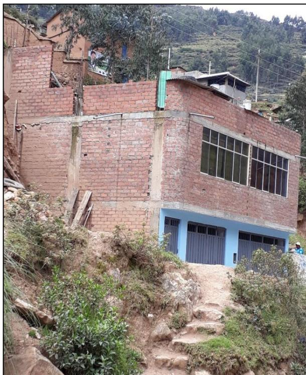
*Fotografía 24.* Vivienda de Albañilería, sin confinamiento de muros, falta conectar correctamente el parapeto al sistema resistente (Vulnerabilidad Media).
