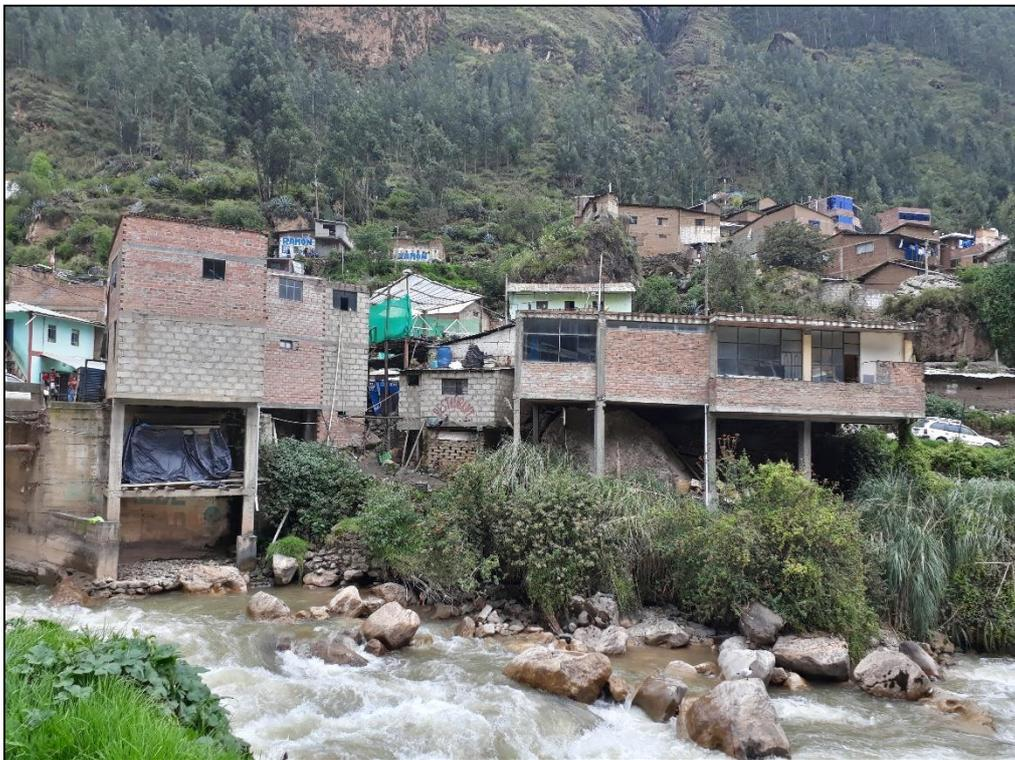
*Fotografía 31.* Edificación, con presencia de piso blando (Vulnerabilidad media).
