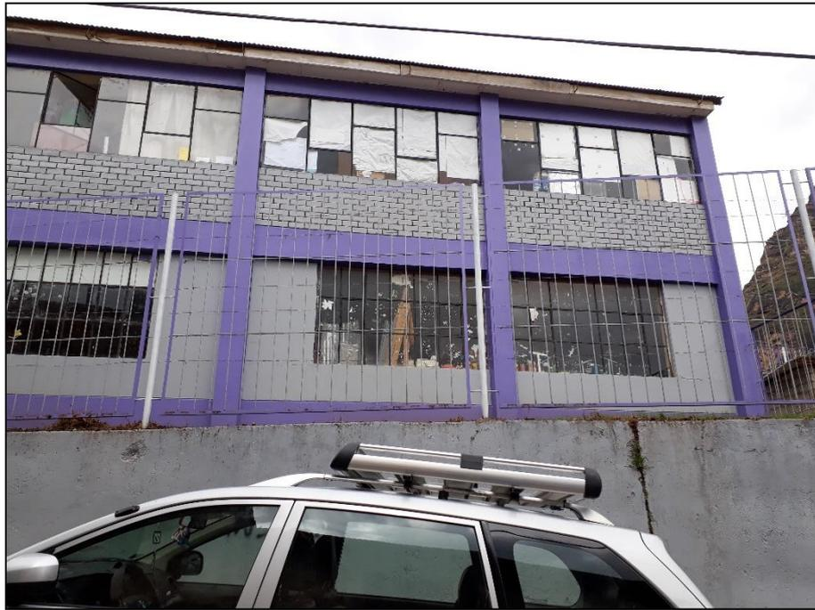
*Fotografía 20.* Edificación con sistema estructural aporticado, con presencia de cambio de rigidez en los pisos, debido a que presenta cobertura liviana y losa aligerada en el piso inferior (Vulnerabilidad media).
