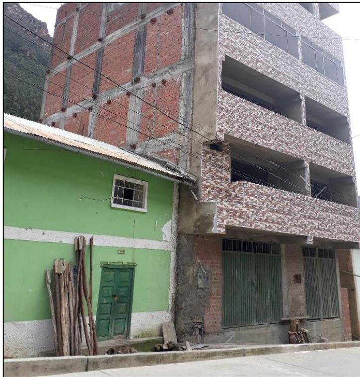
*Fotografía 33. Edificación de albañilería, muros confinados correctamente (Vulnerabilidad Baja).*
