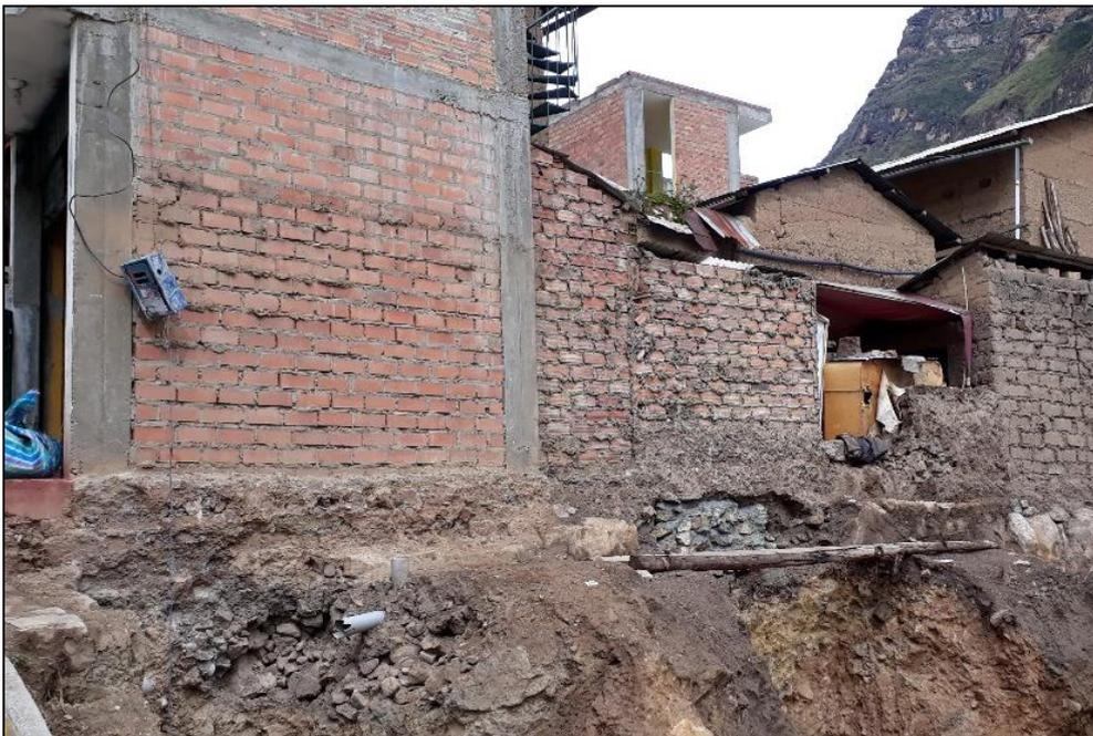
*Fotografía 7.* Edificación de Albañilería con deficiente colocación de mortero, mala distribución de ladrillos y cimentación en pésima condiciones (Vulnerabilidad Alta).
