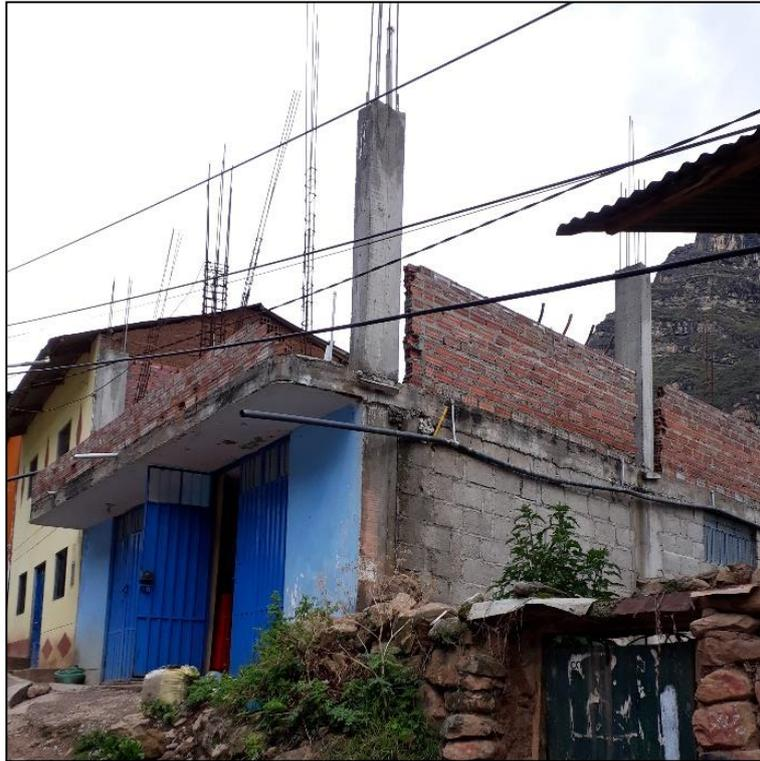
*Fotografía 12.* Edificación de Albañilería con cambio de rigidez en muros; en el segundo nivel se presencia que falta completar la construcción, por ende columnas y muros sin conectar correctamente se presentan vulnerables ante evento sísmico (Vulnerabilidad Media).
