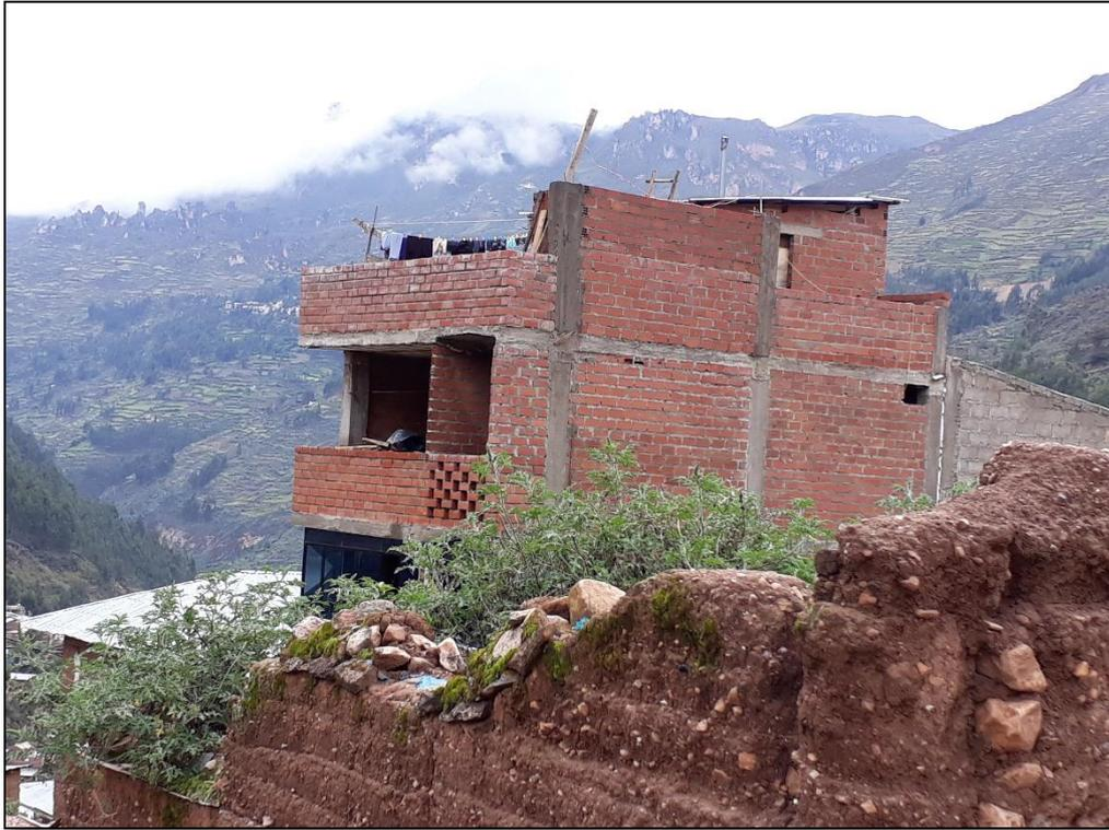
*Fotografía 18.* Edificación de Albañilería que carece de viga solera para confinamiento de muros, parapetos mal conectados y mala distribución de ladrillos y espesor de mortero deficiente (Vulnerabilidad Alta).
