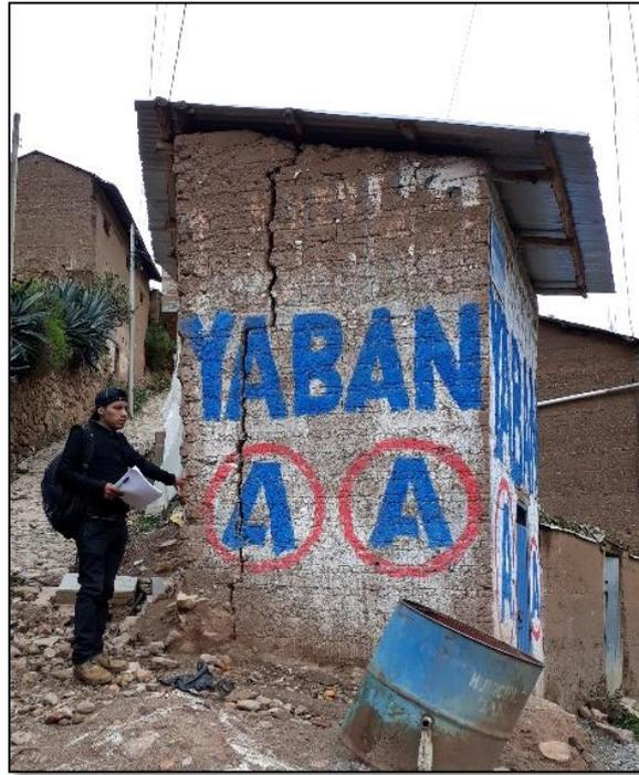
*Fotografía 14.* Agrietamiento de muro en vivienda de Adobe (Vulnerabilidad Alta).
