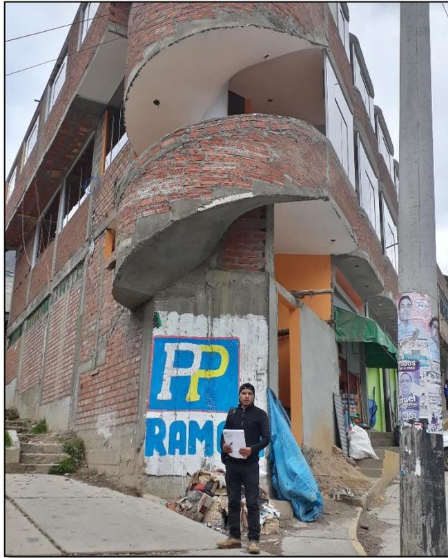
*Fotografía 30.* Edificación de Albañilería, escalera inadecuadamente conectada al sistema estructural de la edificación, y parapetos mal conectados (Vulnerabilidad media).
