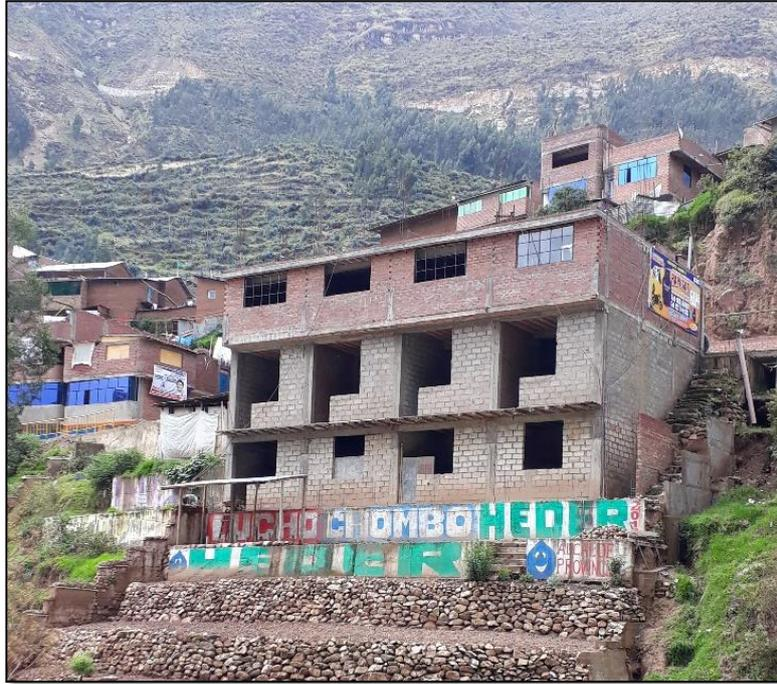
*Fotografía 26.* Vivienda de albañilería con cambio de rigidez en los pisos y muros, pero la distribución de vanos de puertas y ventanas en sus niveles es correcto (vulnerabilidad Media)
