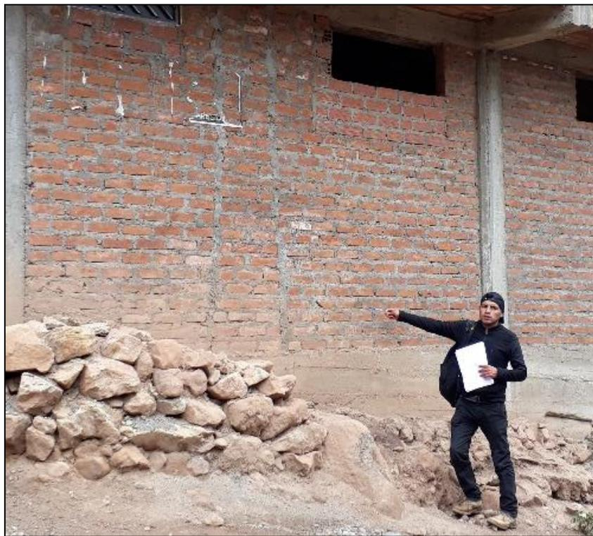
*Fotografía 13.* Deficiente uniformidad de mortero, mala distribución de ladrillo (Vulnerabilidad Media).
