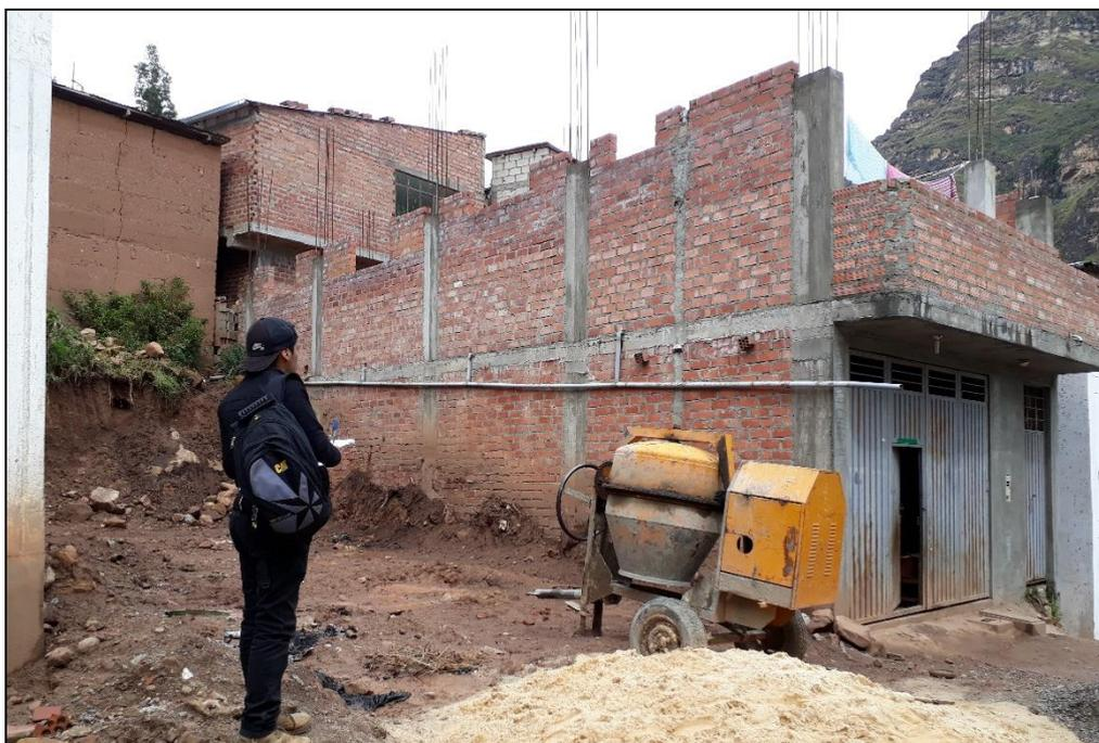
*Fotografía 17.* Vivienda de Albañilería que falta confinar la parte superior, presencia de mala colocación de unidades de albañilería y falta conectar correctamente parapeto (Vulnerabilidad Alta).
