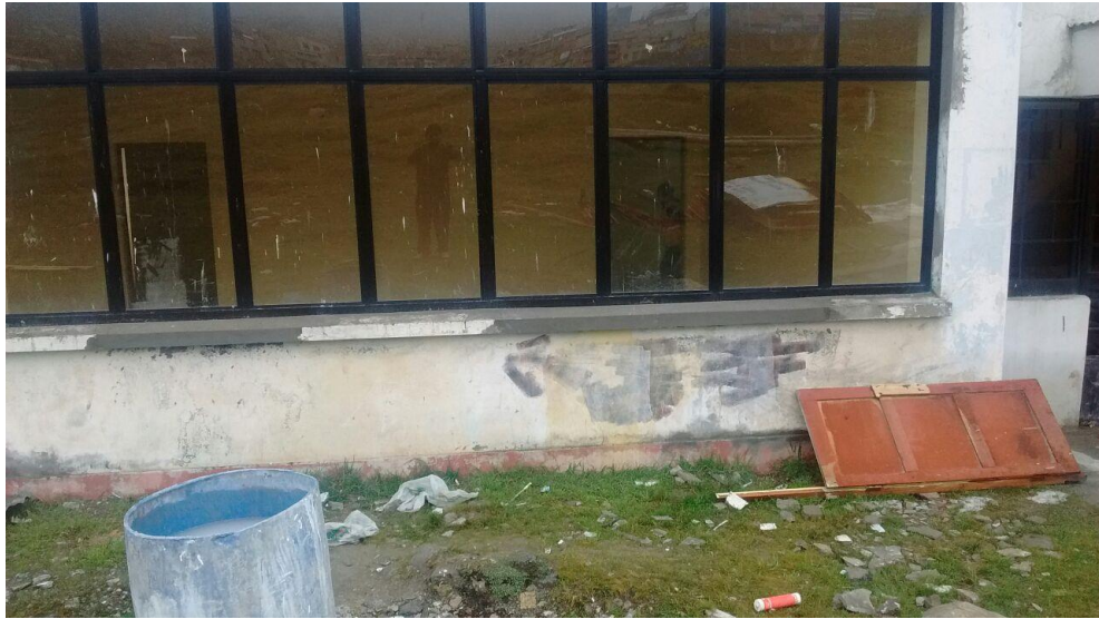
Colocación de nuevas ventanas mas densas.
