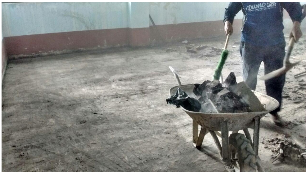
Demolición de Pisos para incorporar otros con mayor densidad.
