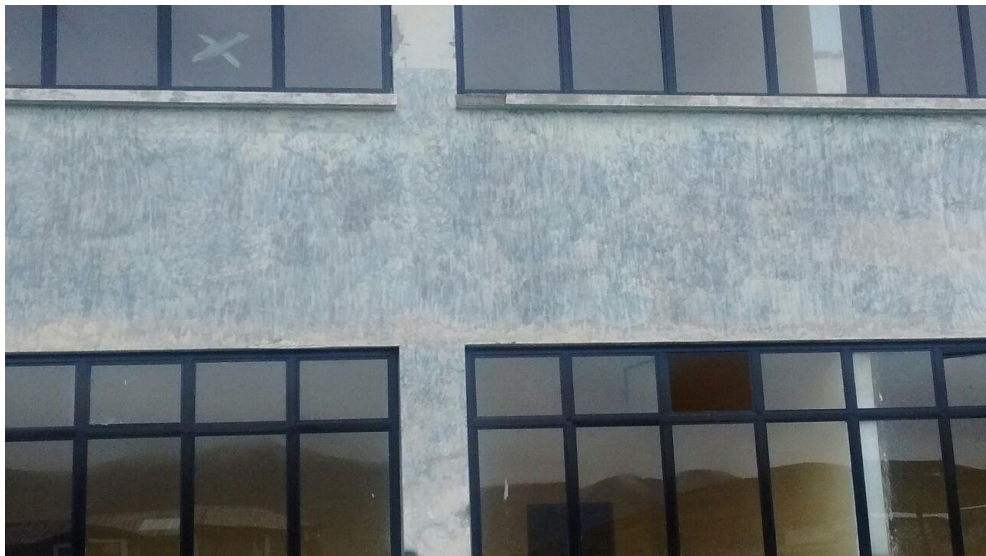
Colocación de nuevas ventanas más densas.
