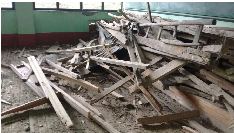
Desmontaje de Pisos Machihembrados
