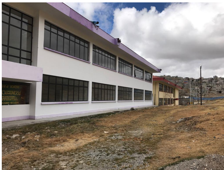
Imagen después del Mantenimiento del Pabellón
