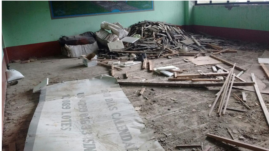
Desmontaje de Pisos Machihembrados
