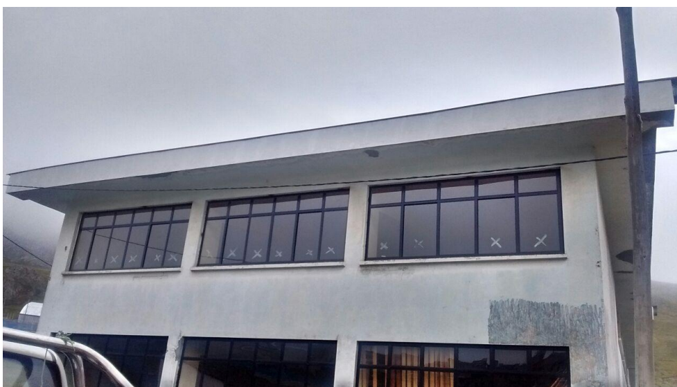
Colocación de nuevas ventanas más densas.
