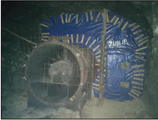
Foto N° 01 y 02: Instalación de Ventilador de 60,000 cfm ubicado en acceso a RB Consuelo NV_2100
