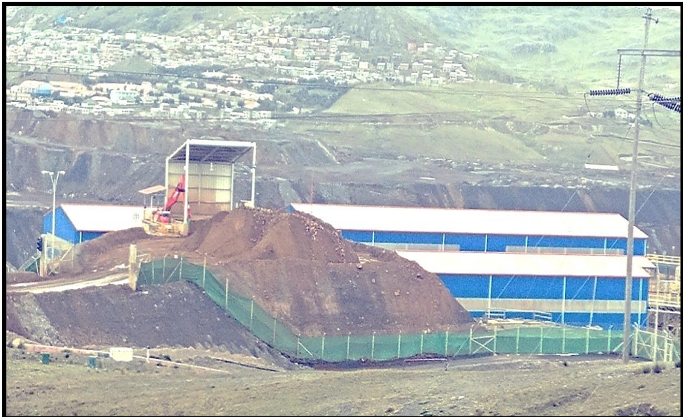
Imagen 4: Actividad de Chancado en la Planta de Óxidos
