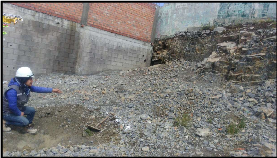
Foto 18. Continuidad del macizo rocoso.
