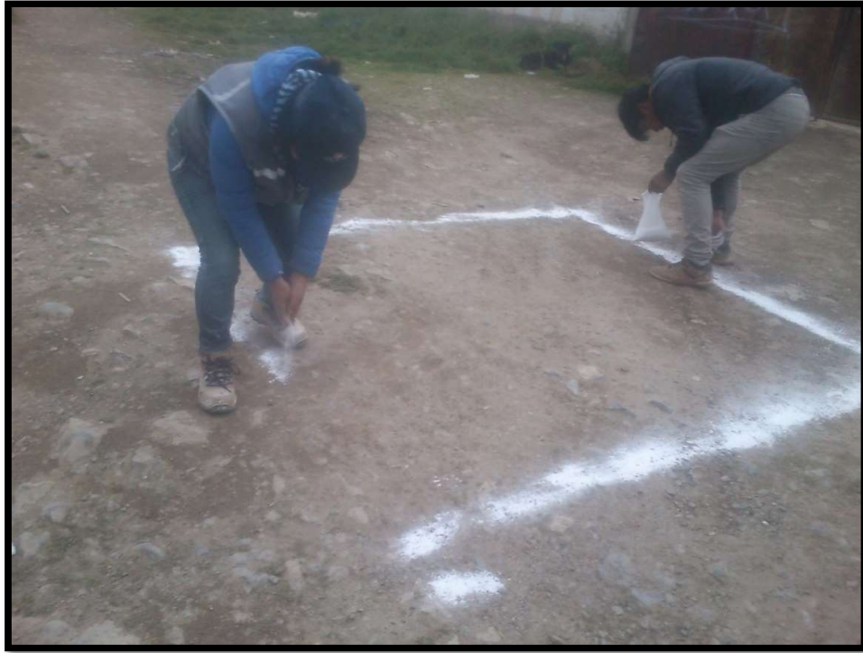
Foto 1. Marcación de la calicata con yeso para el inicio de la excavación.
