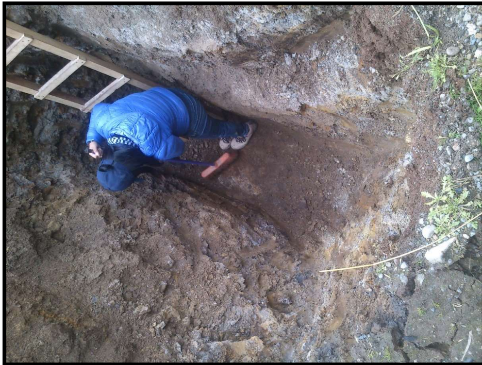
Foto 14. Limpiando la calicata para la identificación de fisuras en la roca.
