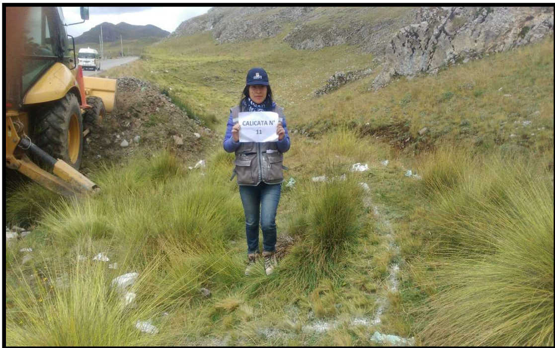
Foto 6. Calicata 11, ubicada en la carretera a 500 m del arco.
