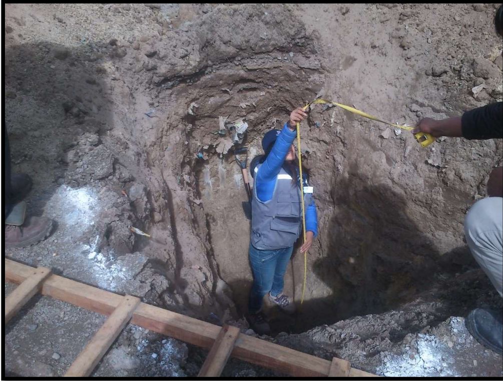
Foto 13. Midiendo la profundidad de la calicata, se encontró roca.
