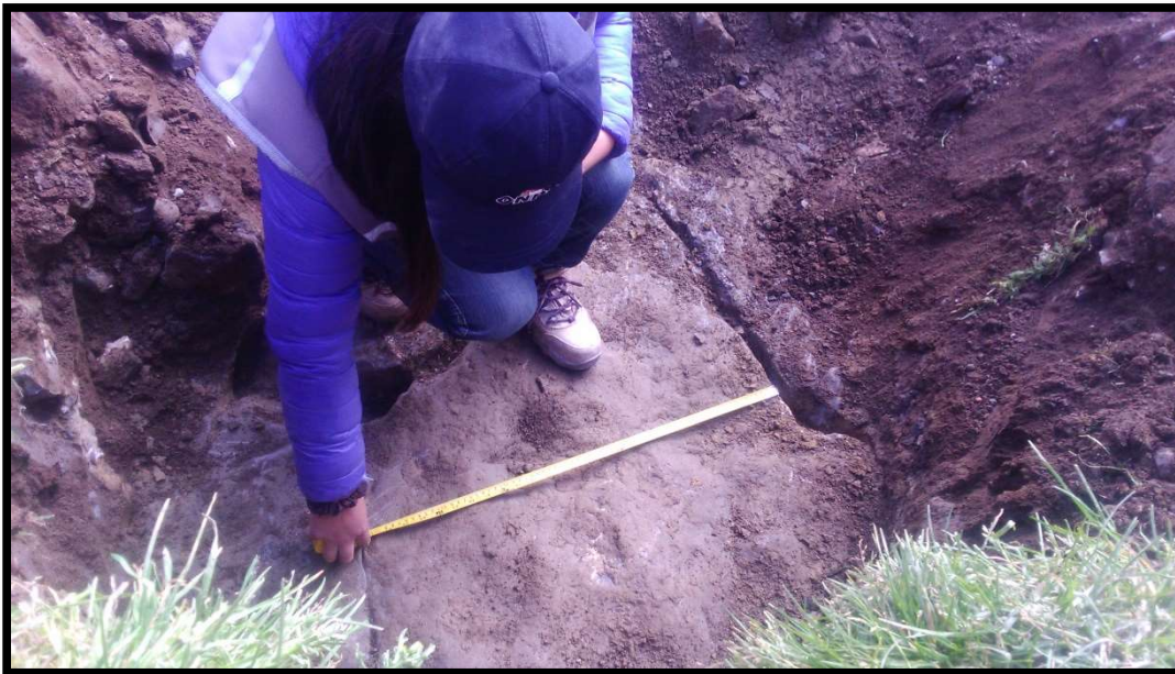
Foto 16. Midiendo la separación de fisuras.
