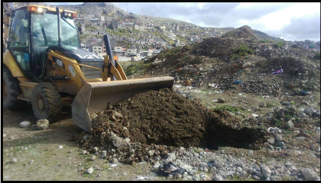
Foto 25. Al término de la toma de muestras e identificación de suelo, roca y estratos, se taparon las calicatas.
