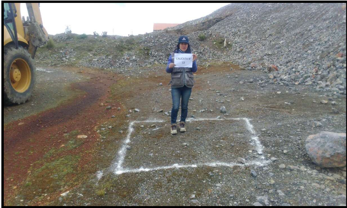
Foto 5. Calicata 12, ubicado en la nueva ciudad de Pucayacu.
