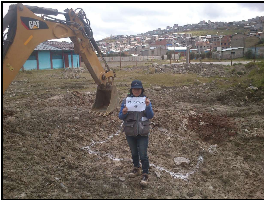
Foto 4. Calicata 5, ubicada en Cancha blanca.
