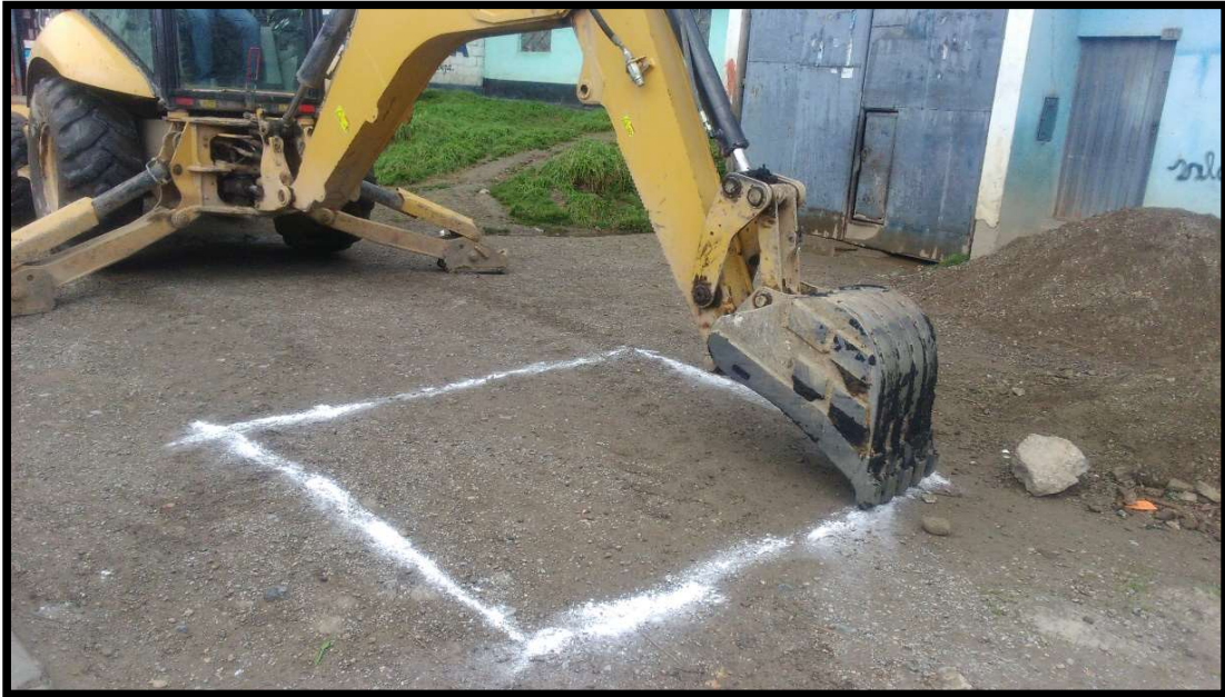
Foto 7. Inicio de excavación con retroexcavadora.
