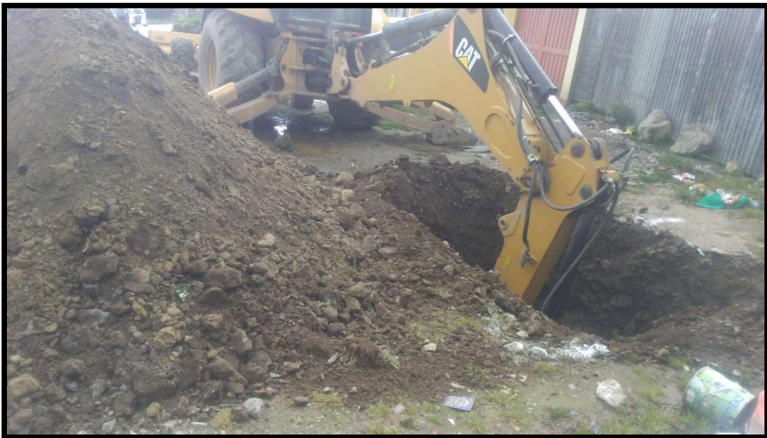
Foto 8. Se excavo hasta llegar a los 3 metros o encontrar roca. El brazo de la retroexcavadora puede llegar hasta 3 m máximo.
