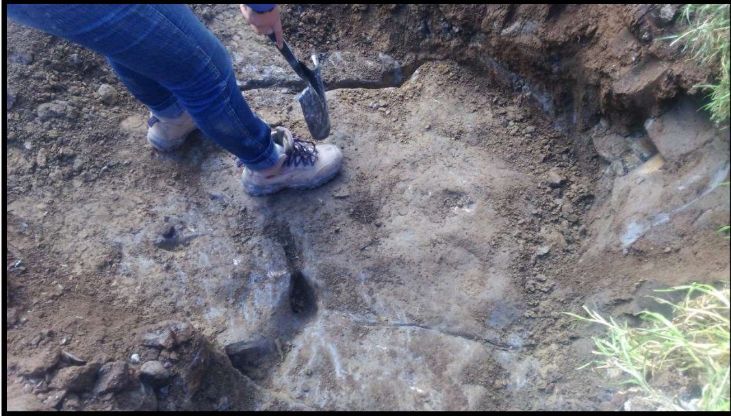
Foto 15. Limpiando las fisuras para medición.
