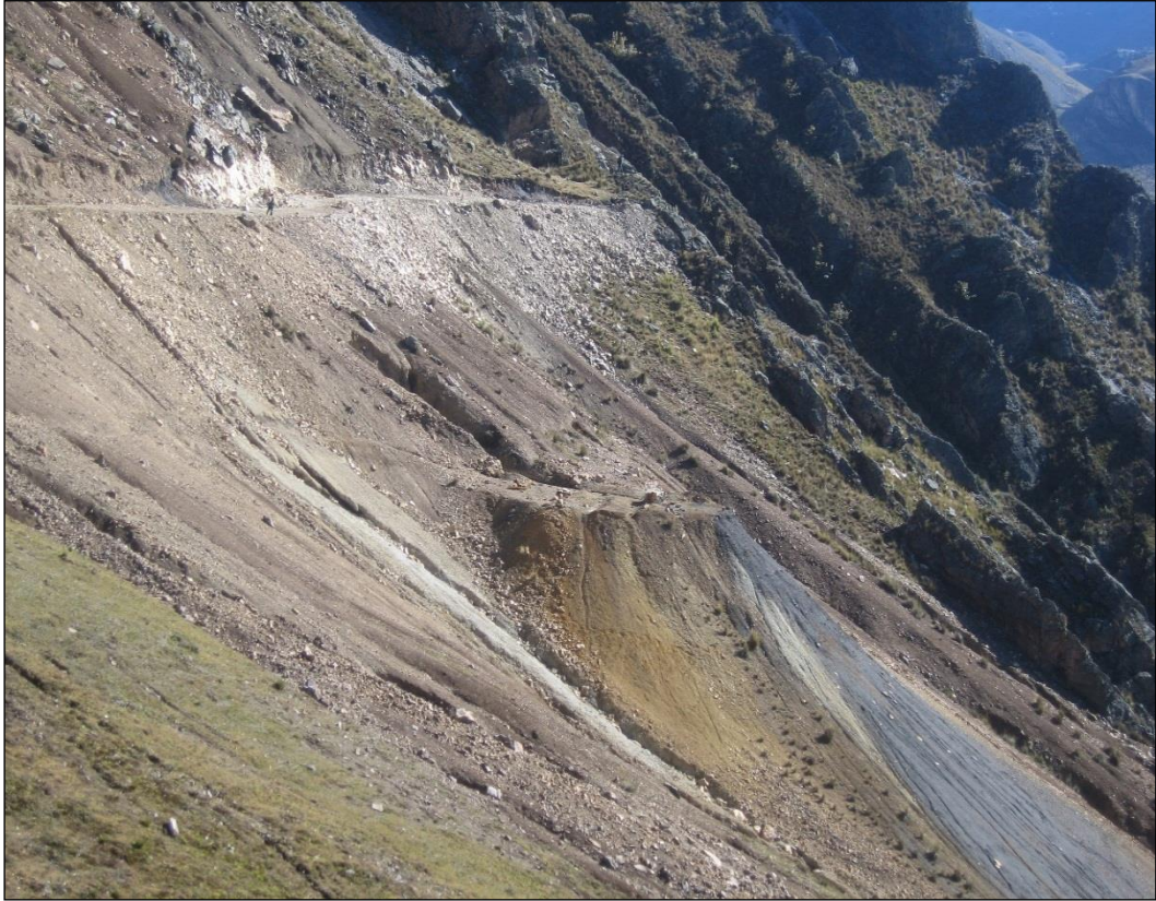
Foto 8. Vista panorámica del Nivel 0. Se observa la cancha de material desmonte.
