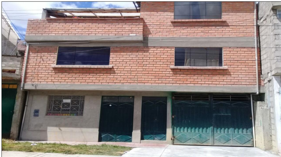
Viviendas de albañilería confinada del Sector Salud del distrito de Yanacancha, las cuales corresponde dentro del estudio.
