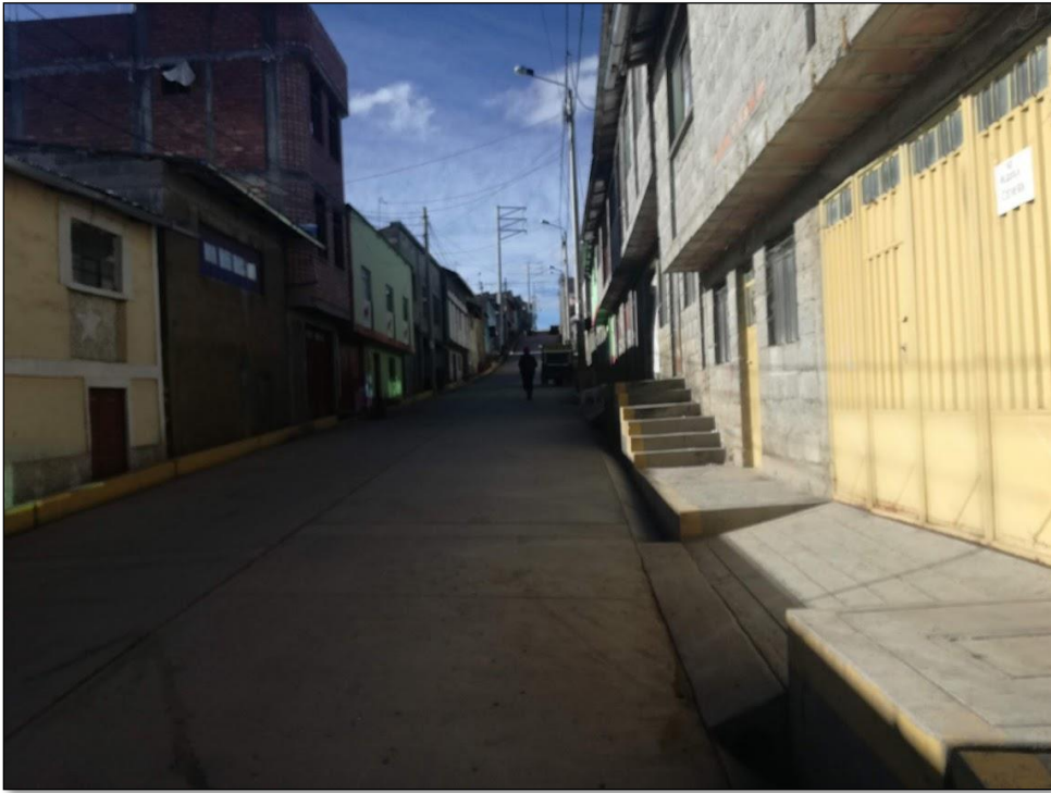
Viviendas de albañilería confinada del Sector Salud del distrito de Yanacancha, las cuales corresponde dentro del estudio.
